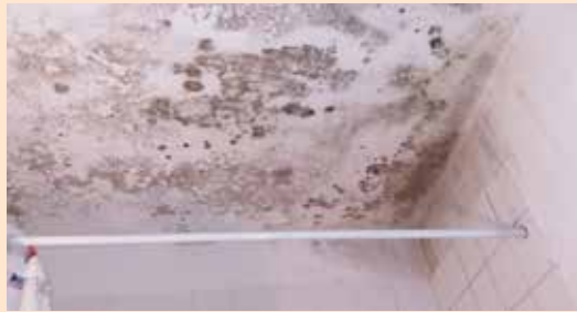
Plafond de la salle de bain.
